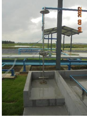
รูปที่ 26 ฝักบัวฉีดน้ำและอ่างล้างตา
